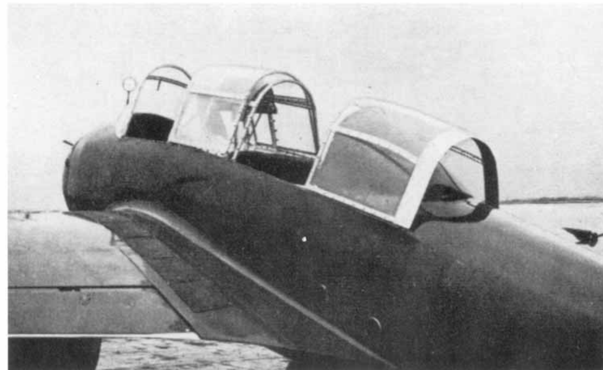
Odsunięte osłony kabiny i chodnik na skrzydle. The opened cockpit hoods and the footway on the wing
